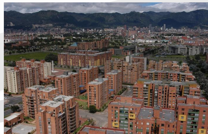
Imagen #21 Proyecto urbanístico Ciudadela Bolonia, ubicado en la localidad de Usme, Ciudad de Bogotá.
