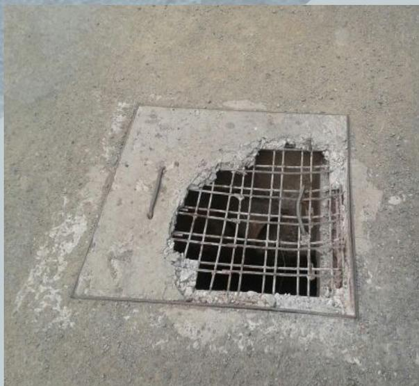
Fig. 2.58 Tapa de registro dañada con huecos
