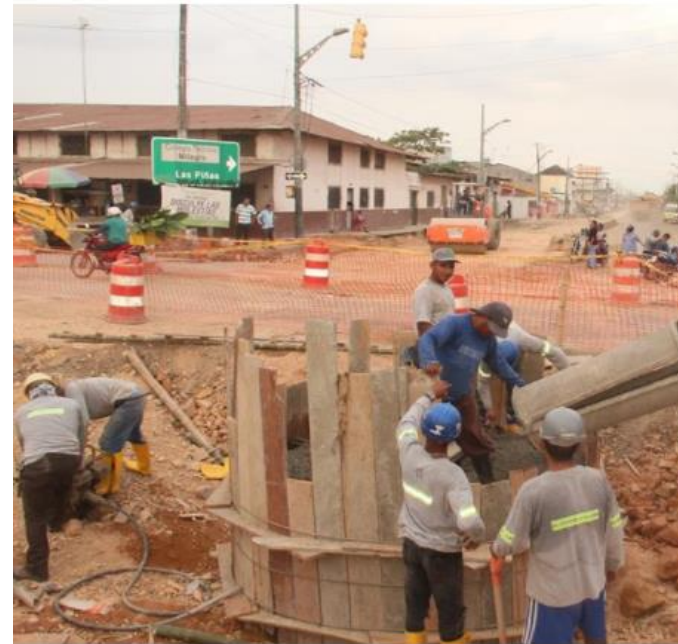
Imagen 16: Obras de infraestructura sanitaria
