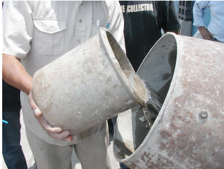
Figura 5, Adición de agua a la mezcla de hormigón.
