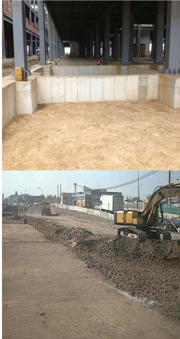
Ilustración 15 Geobloques en lechos de soporte
