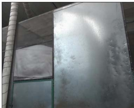
Ilustración 14 Silos de Curado
