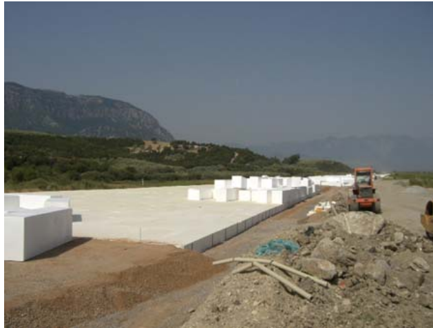
Ilustración 1 Trabajo de ingeniería civil con poliestireno expandido
