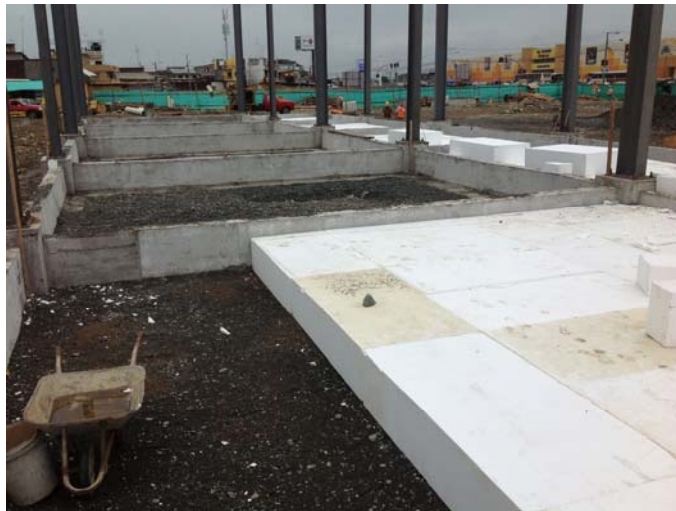
Ilustración 16 Colocación y Corte de Bloques de EPS In Situ
