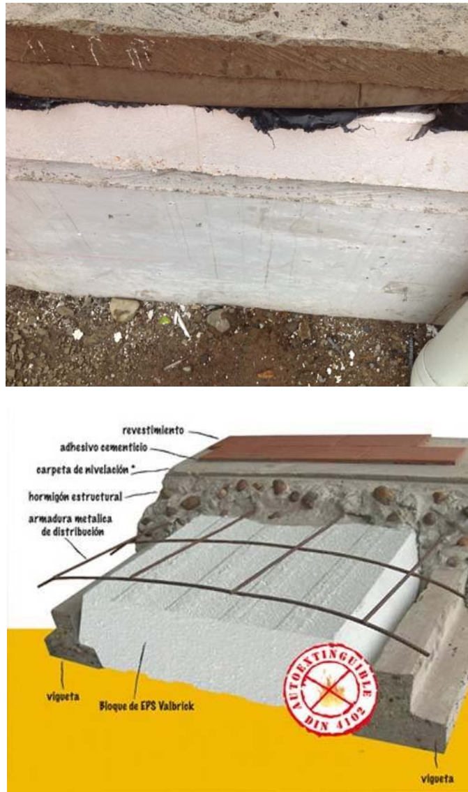
Ilustración 18 Colocación de geobloques
