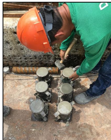
Figura 46. Obtención de testigos del grout en cilindros. Fuente del autor.
