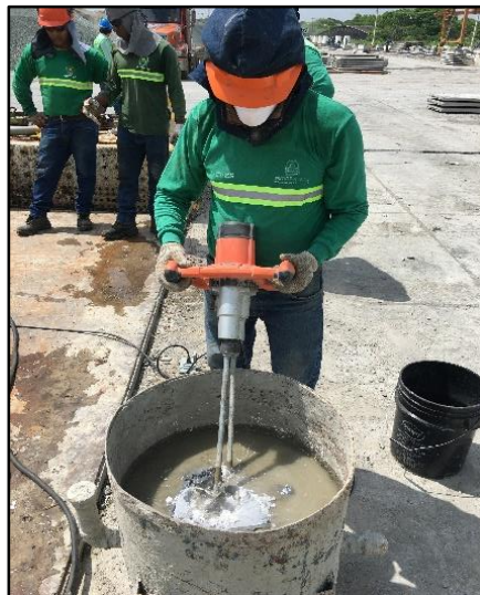
Figura 44. Dosificación y elaboración del mortero tipo grout. Fuente del autor.
