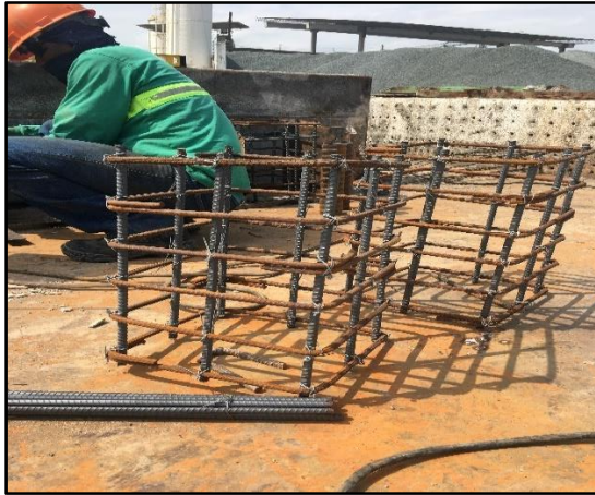
Figura 40. Armado de los bloques de ensayo. Fuente del autor.
