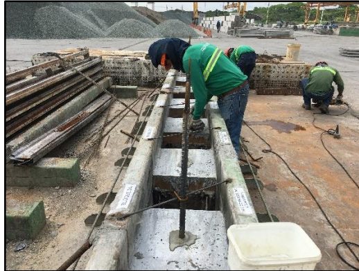
Figura 45. Colocación del mortero tipo grout. Fuente del autor.
