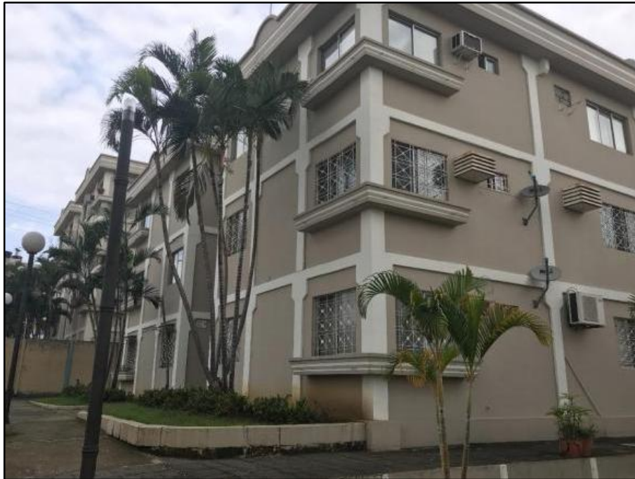
Figura 1. Condominio de la Urbanización San Antonio II construido con elementos prefabricados de hormigón. Fuente del Autor.
