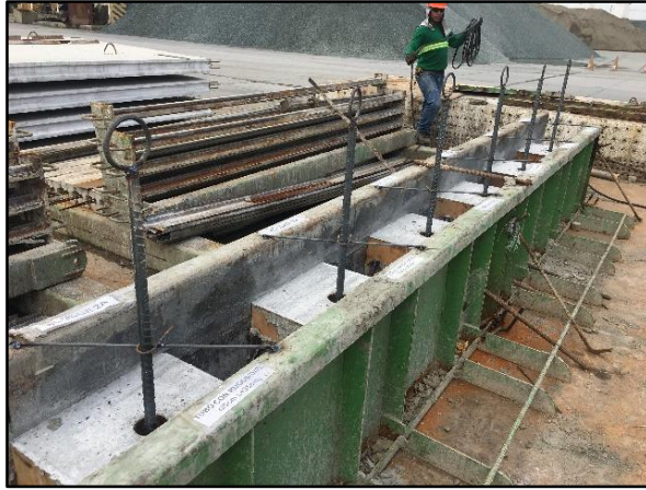
Figura 43. Colocación de la varilla de empotramiento. Fuente del autor.
