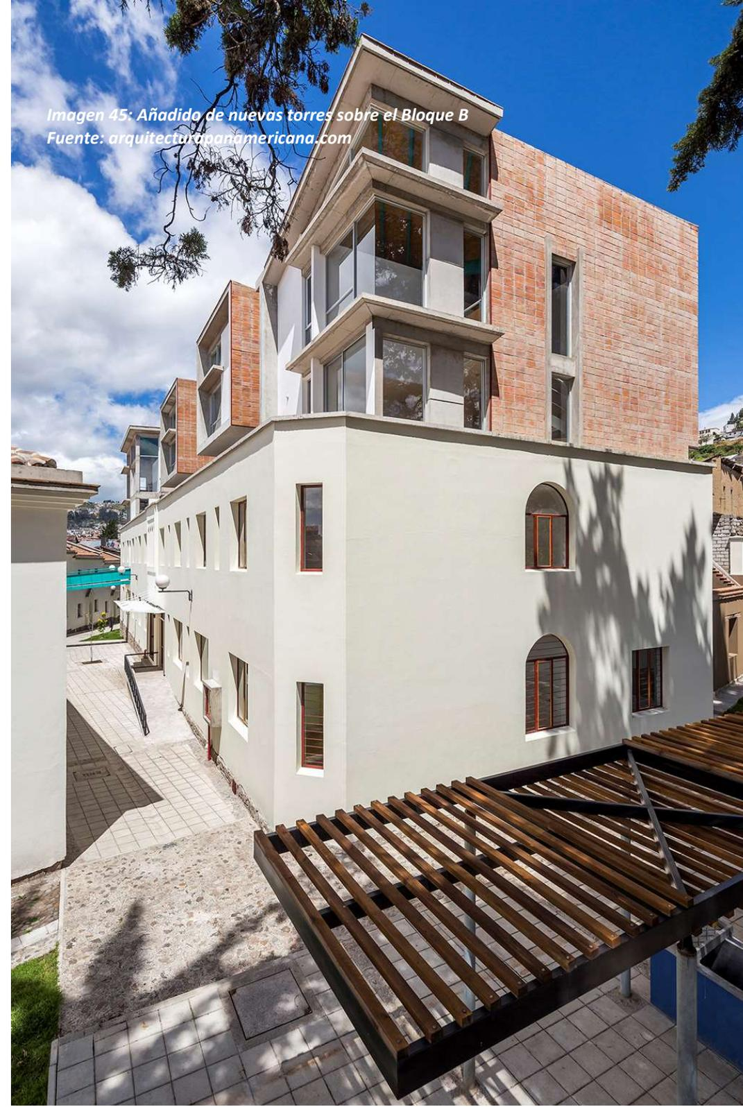
**Imagen 45: Añadido de nuevas torres sobre el Bloque B**
