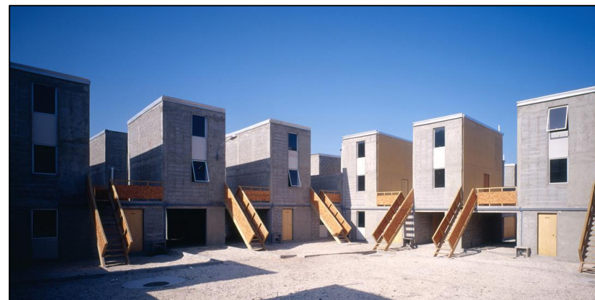
Imagen 24. Vista del Conjunto residencial obra limpia. Fuente: (Elemental S.A 2007).
