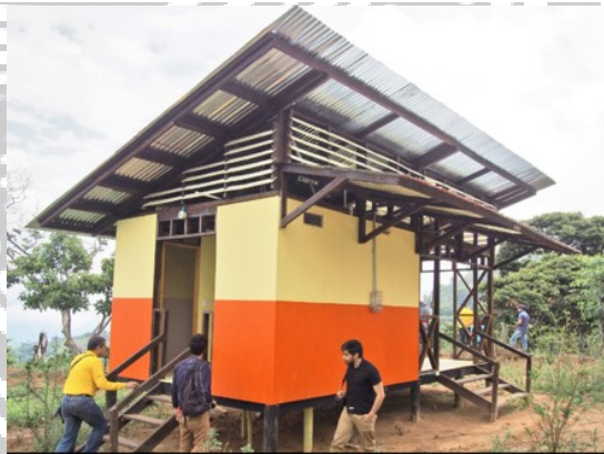
Ilustración 10 Casa de entramado de madera seca, Colombia (Integral, 2017).
