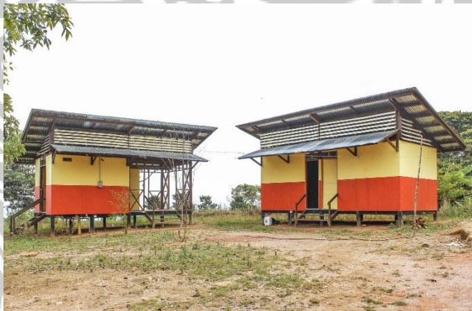
Ilustración 8 Casa de entramado de madera seca, Colombia (Integral, 2017).
