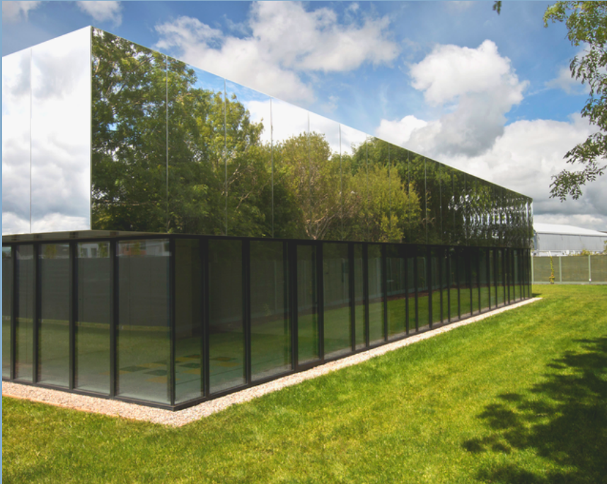
Figura 52 Fachada de Centro Infantil “West Limerick”
