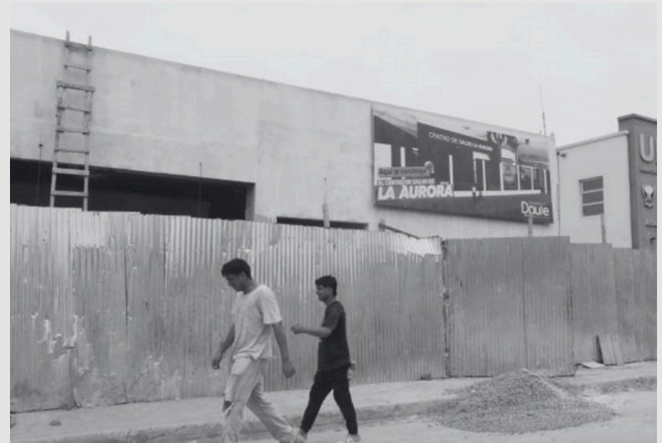
Imagen 8. Construcción de un centro de salud A
