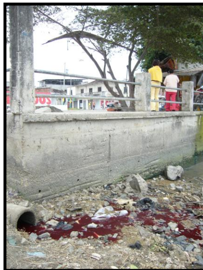
Foto 20: Falta de Infraestructura del Camal Municipal
