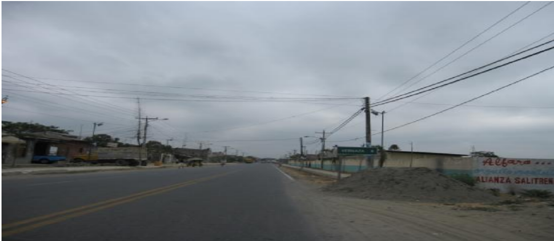
Figura 3.26. Vía a Vernaza Fuente: Autoría propia.
