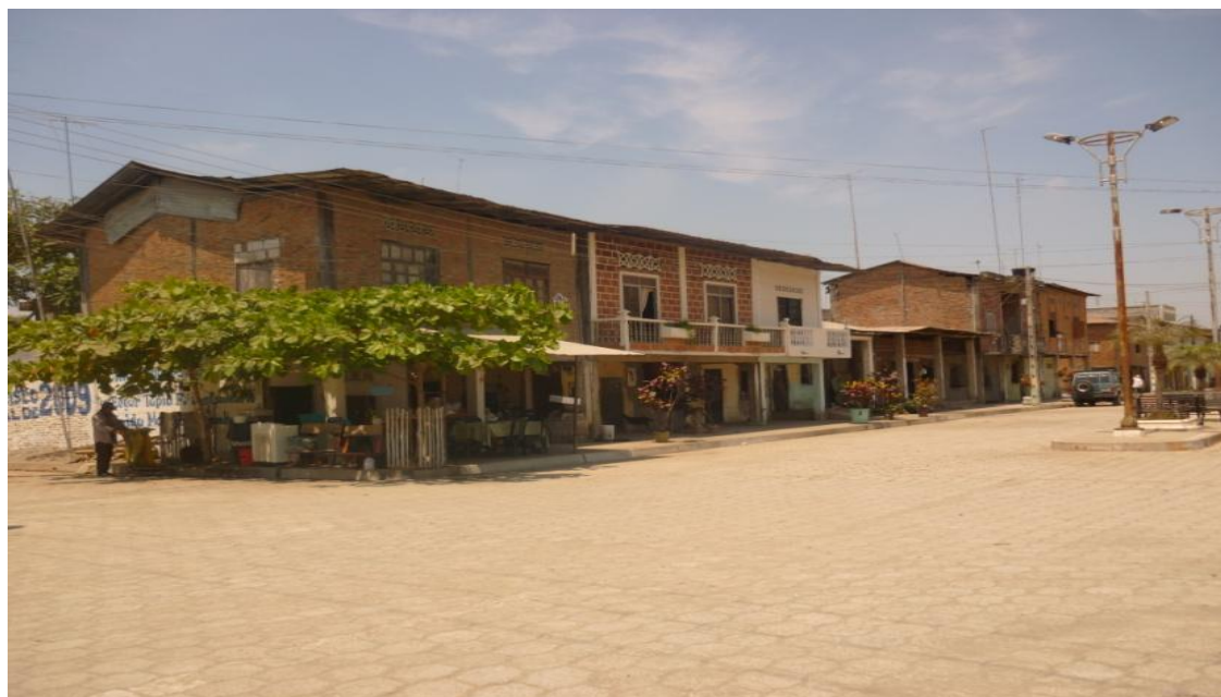
Figura 3.31. En esta fotografía observamos que las viviendas están construidas de hormigón y madera, que es mixto. Fuente: Propia Autoría.
