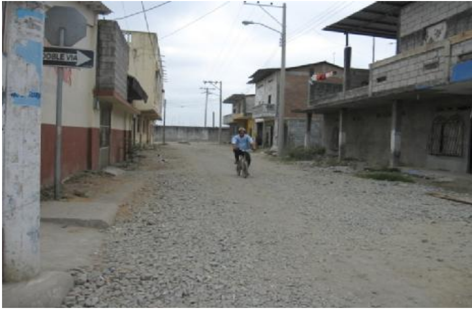
Figura 3.20 Calle Pio Poveda - Calle Terciaria Fuente: Autoría propia
