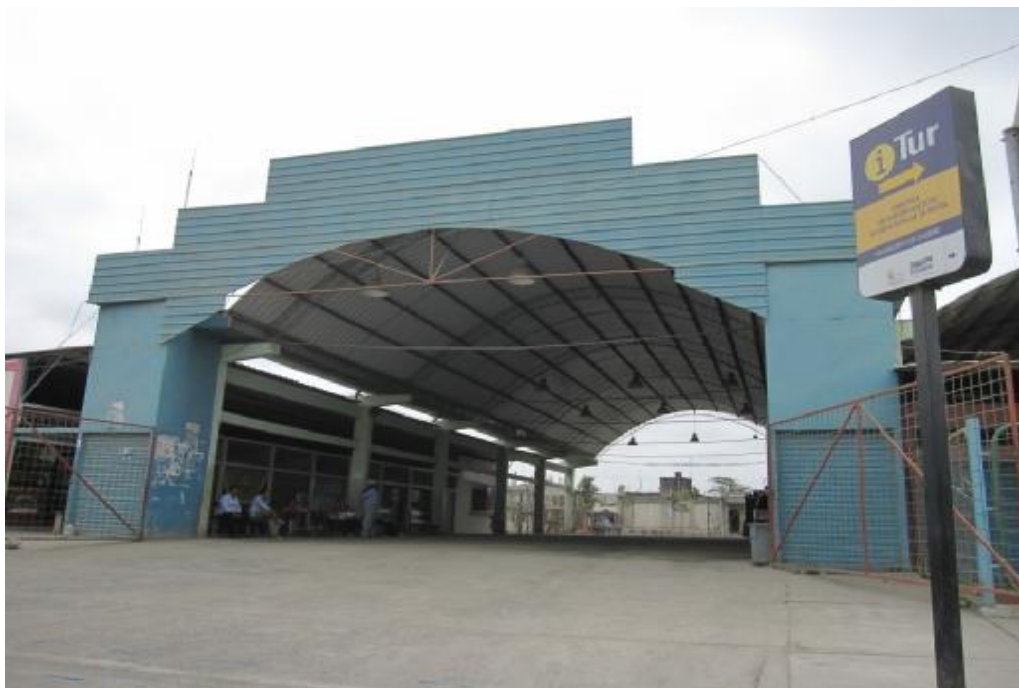
Figura 3.25. Terminal Terrestre/Mercado Central. En la imagen se puede apreciar el actual terminal terrestre concebido para ubicar las ferias artesanales y puestos de comida de quienes habitan el sector, pero debido a desinformación con respecto a la habitualidad de sus pobladores y a que no existen normativas para su reubicación, estos aún permanecen en su ubicación de origen, quedando la presente estructura inutilizable.
