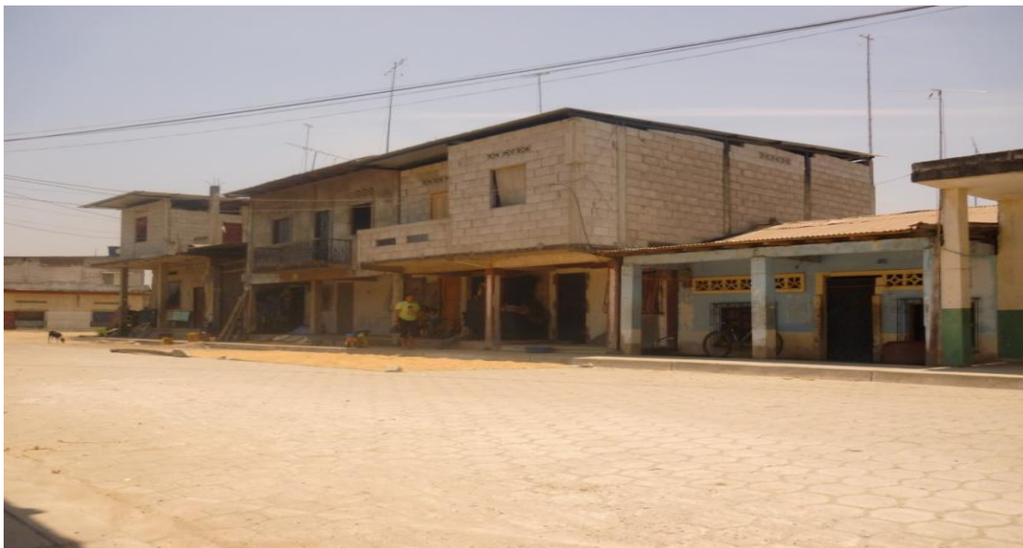
Figura 3.32. En esta imagen se aprecia que en su mayoría las viviendas están construidas de hormigón.
