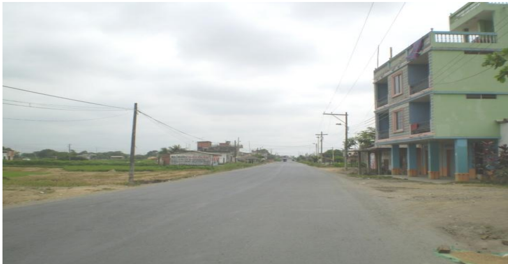
Figura 3.17 Vía a Vernaza – Calle Primaria. Fuente: Autoría propia.
