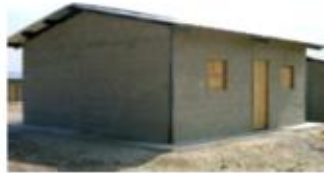
Casa de estructura metálica con paredes bloque. 6.00 x 6.00mts
