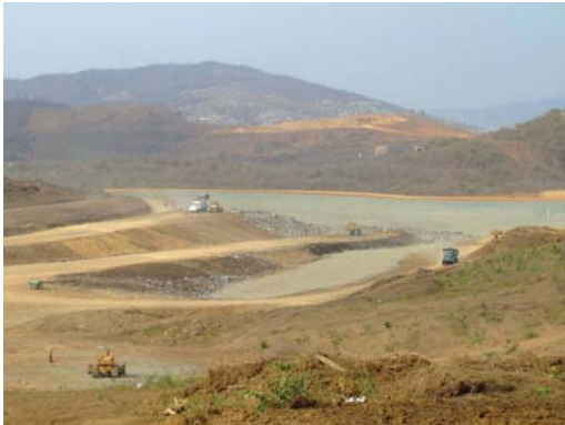
Foto 93, Trabajos de compactación de desechos. Fuente: Eastern Research Group, Inc y Carbon Trade, Ltd. 2007.
