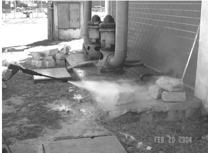
Foto 31, Lavado a presión de las piezas de hormigón para eliminar contaminantes. Fuente: Revista Materiales de Construcción, 2007, España.
