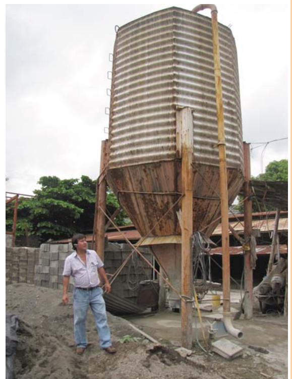
Foto 147, Tolva de cemento, BLOCK S.A. Fuente: G. Pérez/S. Almeida
