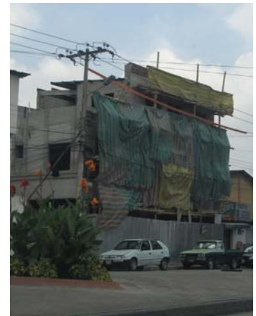
Foto 89, Remodelación de edificio ubicado en Ciudadela La Alborada. Fuente:G. Pérez/S. Almeida
