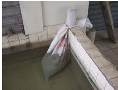
Foto 136, Presaturación de los agregados reciclados. Fuente: G. Pérez/S. Almeida
