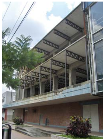
Foto 88, Remodelación antiguo edificio Cine Maya, URDESA. Fuente:G. Pérez/S. Almeida
