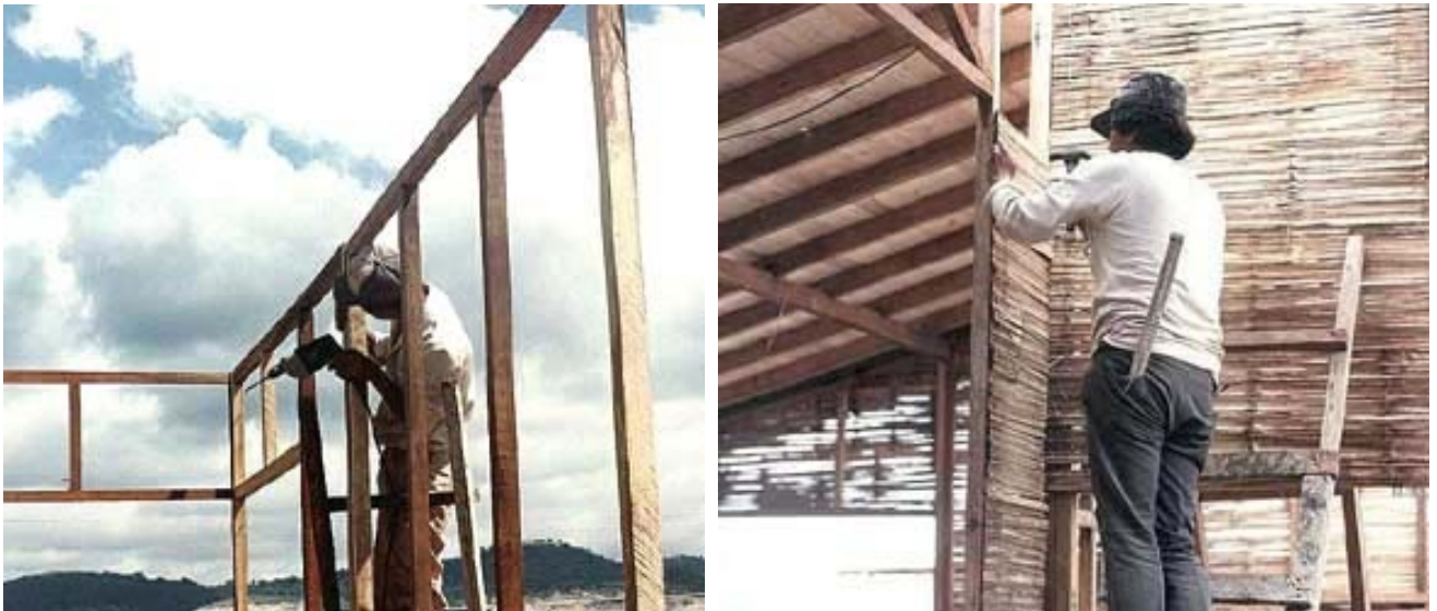
Foto 26, Elaboración de paredes. Fuente: Construcción de casa con caña guadúa en Guayaquil, www.douglasdreher.com
