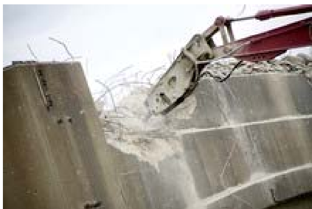
Foto 18, Demolición de estructura de hormigón armado. Fuente: www.aranzadi.es
