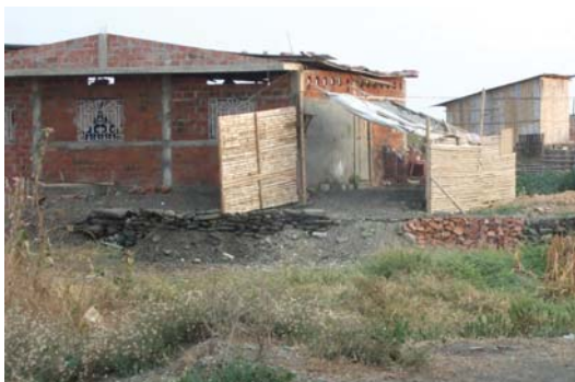
Foto 111, Residuos de carpeta asfáltica y mampostería sobre canal natural. Horama González, Durán. Fuente: G. Pérez/S. Almeida
