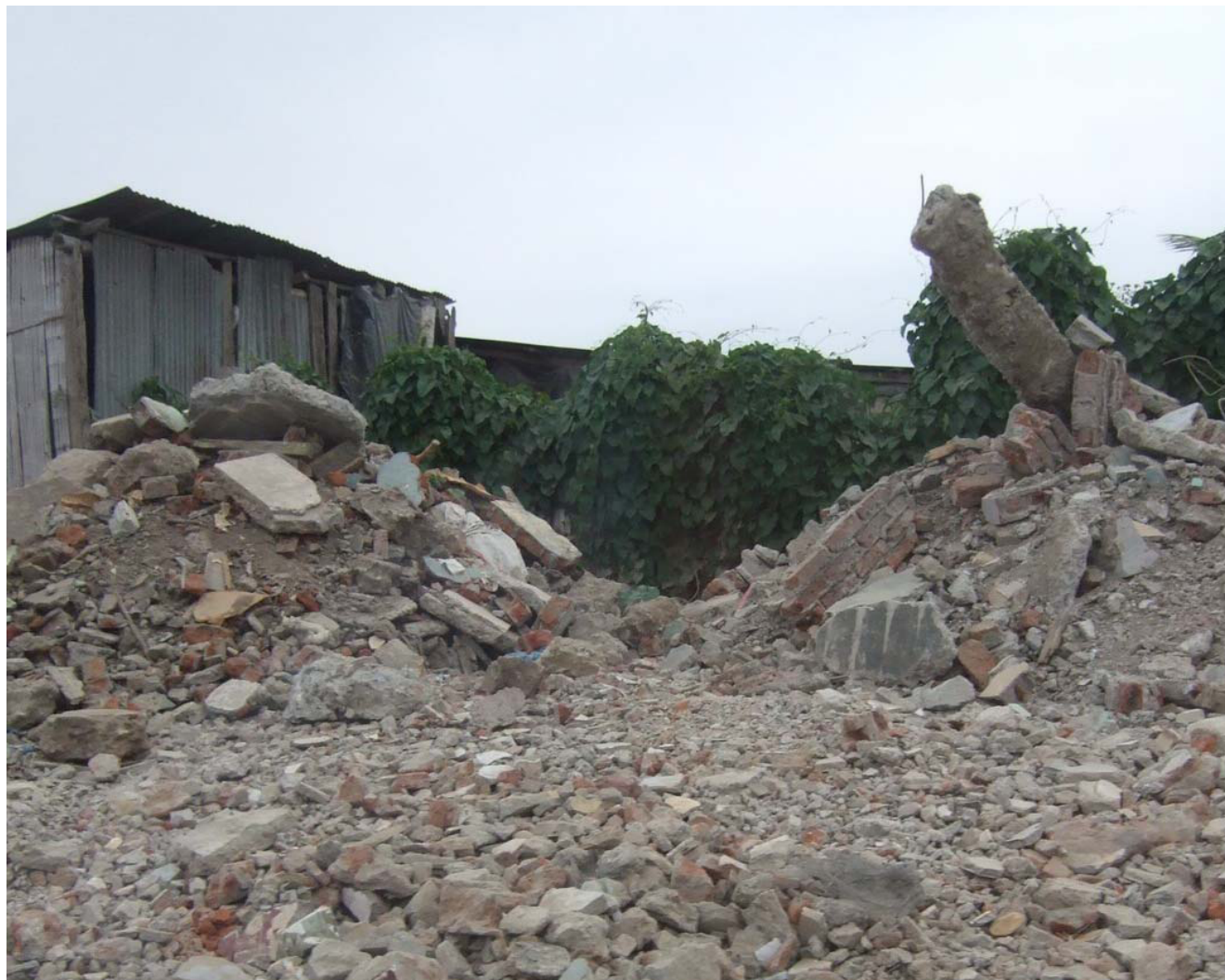
Foto 10. Residuos de demolición sobre la vía pública. Isla Trinitaria, 2008. Fuente: G. Pérez/S. Almeida
