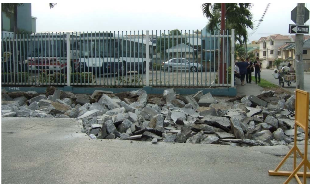
Foto 5, Trabajos de demolición de hormigón simple de aceras, Av. de Las Américas, Guayaquil, 2008. Fuente: G. Pérez/S. Almeida
