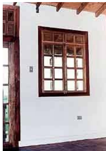
Foto 27, Acabado final de paredes. Fuente: Construcción de casa con caña guadúa en Guayaquil, www.douglasdreher.com
