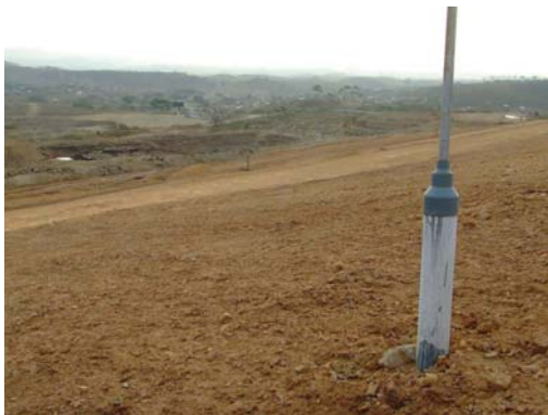
Foto 94, Talúd típico después de rellenado con respiradero. Fuente: Eastern Research Group, Inc y Carbon Trade, Ltd. 2007.
