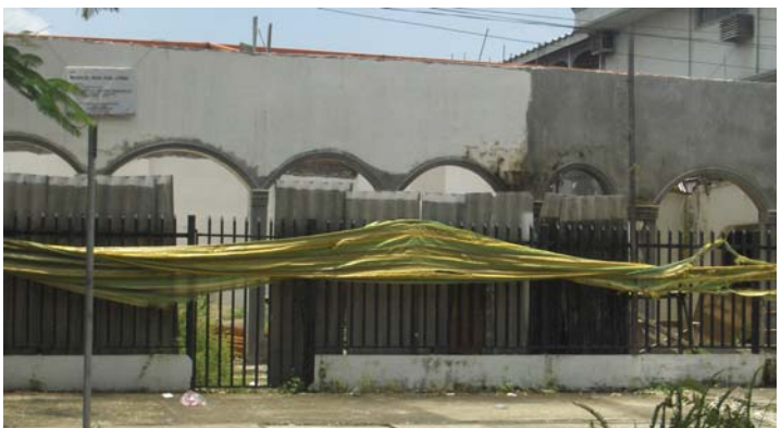
Foto 91, Remodelación de vivienda existente en Av. Las Monjas, URDESA. Fuente:G. Pérez/S. Almeida
