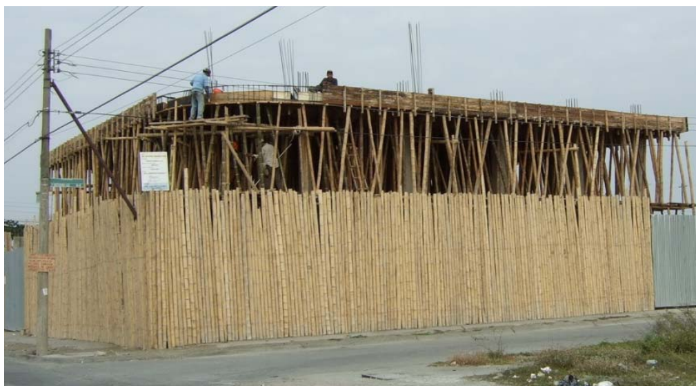
Foto 24, Trabajos de fraguado de losa de hormigón armado, Ciudadela La Garzota, Guayaquil, 2008. Fuente: G. Pérez/S. Almeida
