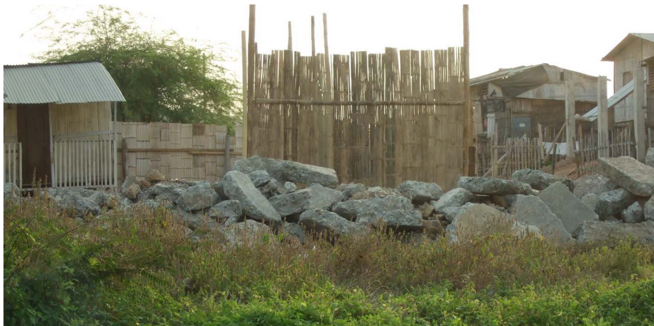
Foto 6, Residuos provenientes de la rotura de pavimentos. Durán, 2008. Fuente: G. Pérez/S. Almeida
