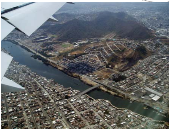
Foto 86, Fotografía aérea Parroquia Febres-Cordero, paso de la Av. Barcelona Sporting Club. Fuente: www.skycrapercity.com
