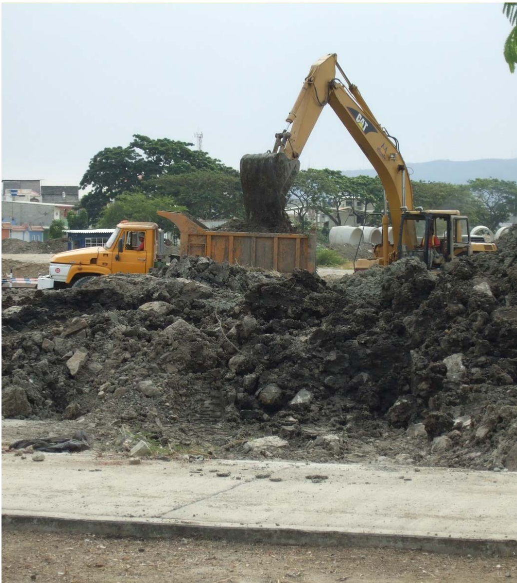
Foto 7, Trabajos de excavación, Terrenos del ISSFA, Guayaquil, 2008. Fuente: G. Pérez/S. Almeida
