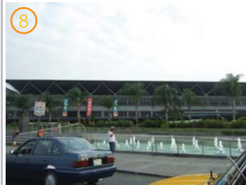
Foto 49, Fachada Principal Terminal Terrestre Fuente: G. Pérez/S. Almeida
