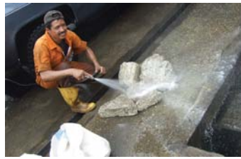
Foto 121, Prelavado de las piezas de hormigón original Fuente: G. Pérez/S. Almeida
