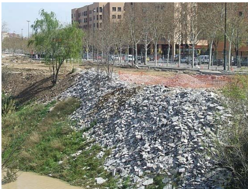
Foto 13, Escombros en las riberas del Puente de La Almozara, España. Fuente: www.sekano.es
