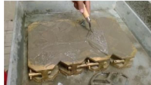
Vaciado de mezcla de mortero en moldes
